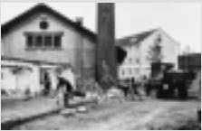
1353 » Instandsetzungsarbeiten, 1933 Foto: Friedrich Franz Bauer im Auftrag der SS Bundesarchiv, Berlin Repair work, 1933 Photo: Friedrich Franz Bauer, commissioned by the SS
